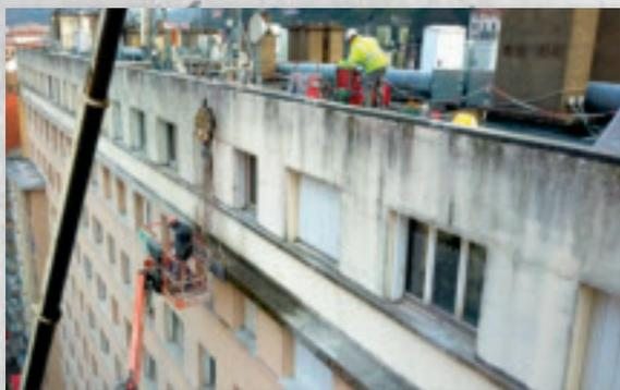
Sciage au câble diamanté pour travaux inaccessibles à la scie.
