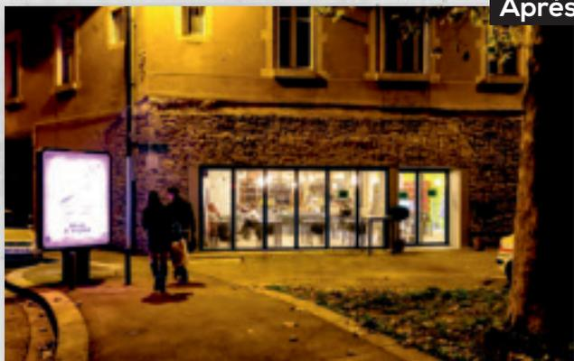
Percement d'une ouverture de 8 m de large sur un immeuble de 3 étages. Murs de 80 cm d'épaisseur (La Buvette - Bourg en Bresse).
