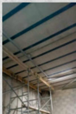
Renforcement d'un plancher en lamelles de carbone.
