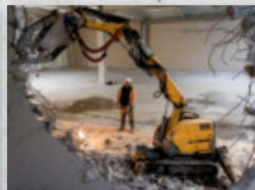
Pour des lieux confinés, DBTS réalise des démolitions sans émission de gaz grâce à un robot démolisseur électrique.
