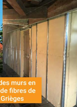
Isolation des murs en panneaux de fibres de bois à Grièges
