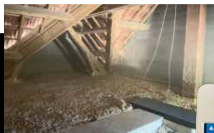
Isolation des rampants et murs à Feillens
