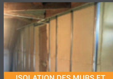
ISOLATION DES MURS ET RAMPANTS EN PANNEAUX DE FIBRES DE BOIS À GRIÈGES
