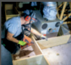
INSTALLATION D'UNE VENTILATION
