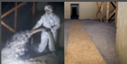
ISOLATION PAR SOUFFLAGE
