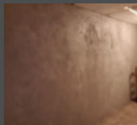
TRAITEMENT DE L'HUMIDITÉ DES MURS
