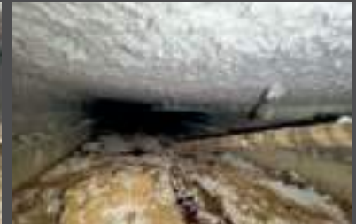
ISOLATION PAR FLOCAGE DU VIDE SANITAIRE
