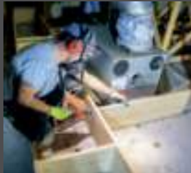
INSTALLATION D'UNE VENTILATION
