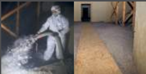
ISOLATION PAR SOUFFLAGE
