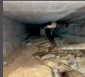
ISOLATION PAR FLOCAGE DU VIDE SANITAIRE
