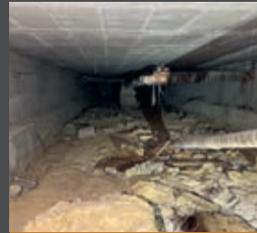
ISOLATION PAR FLOCCAGE DU VIDE SANITAIRE
