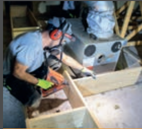
INSTALLATION D'UNE VENTILATION
