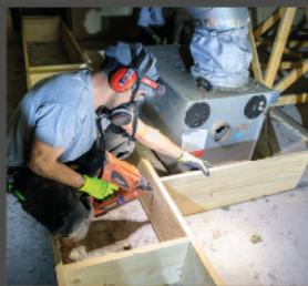
INSTALLATION D'UNE VENTILATION
